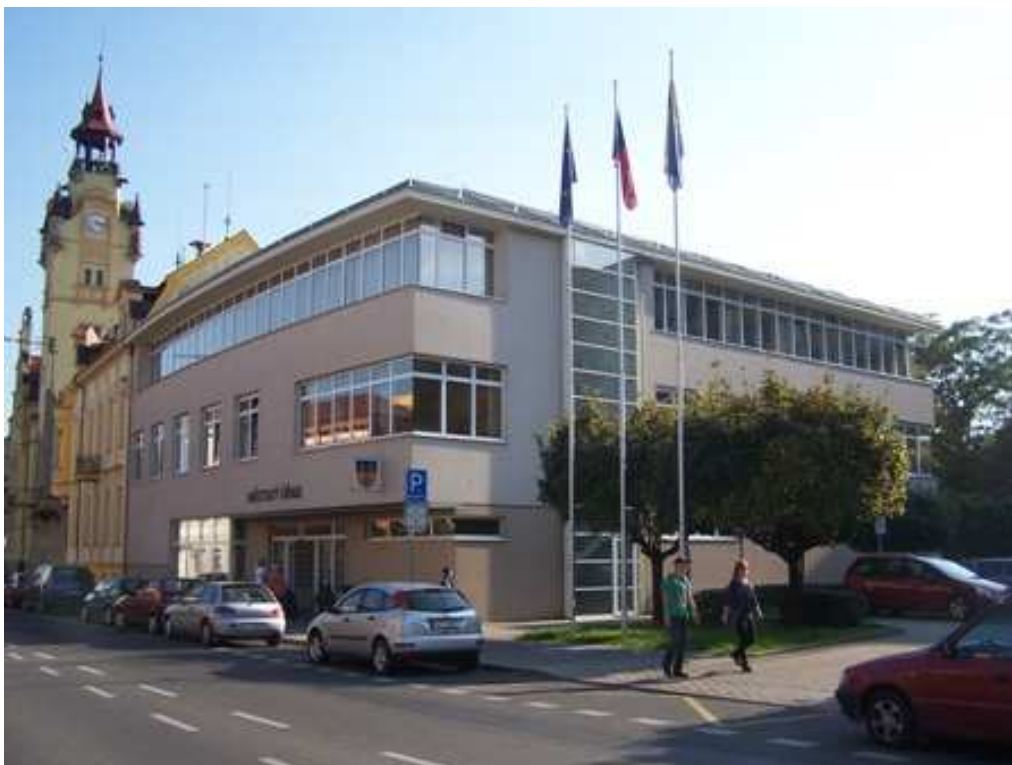
Budova Městského úřadu, Školní 407/2
