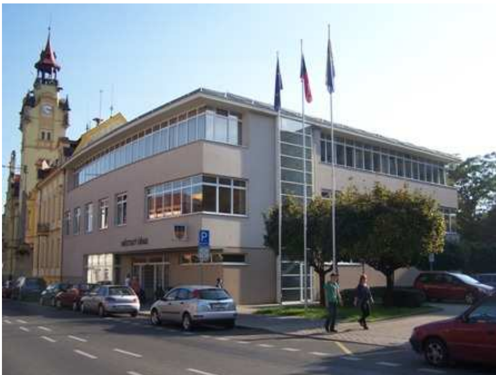
Budova Městského úřadu, Školní 407/2
