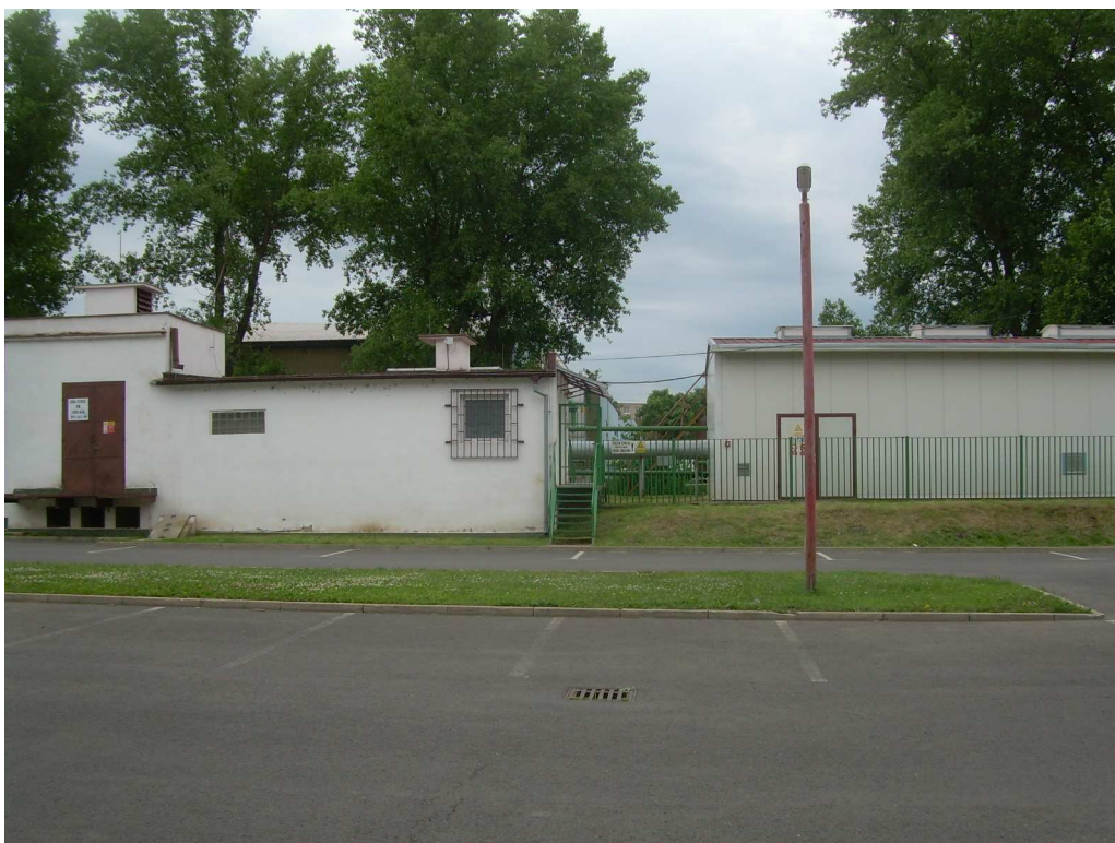
Trafostanice, čpavkové hospodářství
