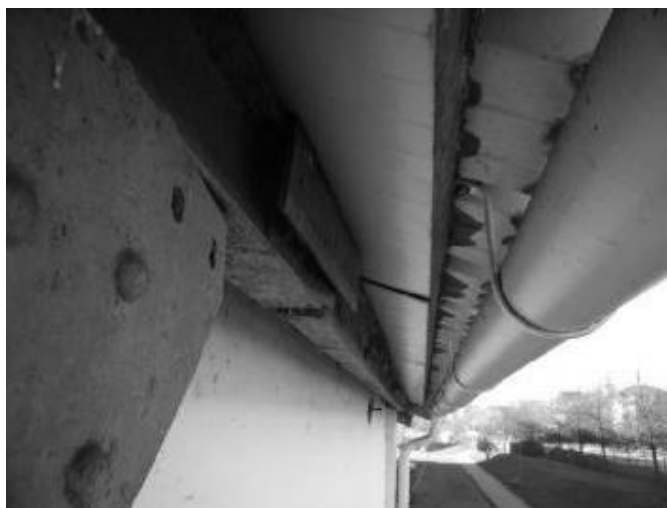
Polyuretanová pěna uvnitř střešních panelů
