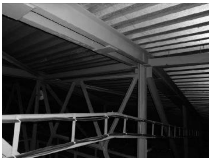
Ocelové příhradové nosníky střechy
