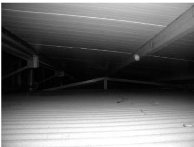
Střešní panely a plechový podhled nad hledištěm
