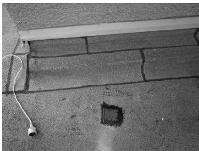
Střecha ubytovny, sonda po opravě
