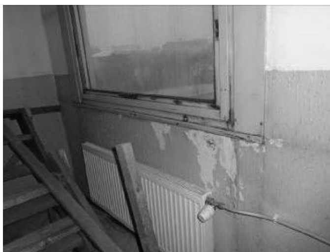
Místo odběru vzorku na přítomnost azbestu
