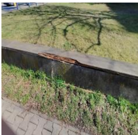
Rozpadající se betonová zídka se dřevěným sedákem.
